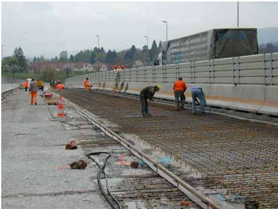
Vorbereitungsarbeiten für den Flächenbeton
