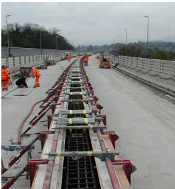
Fertig geschalte Mittelleitmauer
